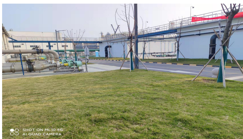
图 4.2.3-5 厂内现场绿化情况
