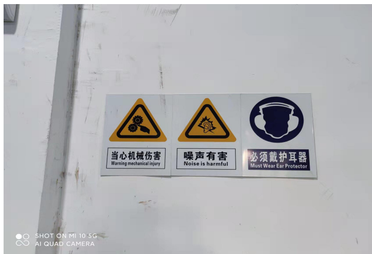
图 4.1.3-1 鼓风机房等现场噪声标识
