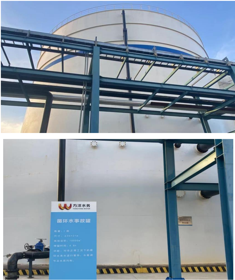
图 4.2.1-1 有效容积 10000m³事故罐
