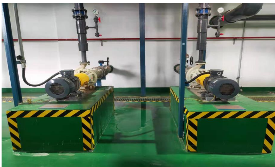
图 4.2.1-2 循环水废水池及循环水废水泵
