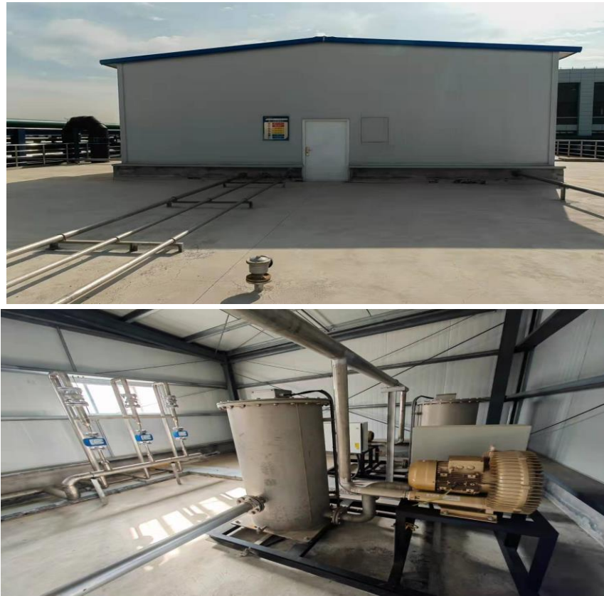
图 4.1.2-1 臭氧接触池加盖、臭氧尾气破坏装置
