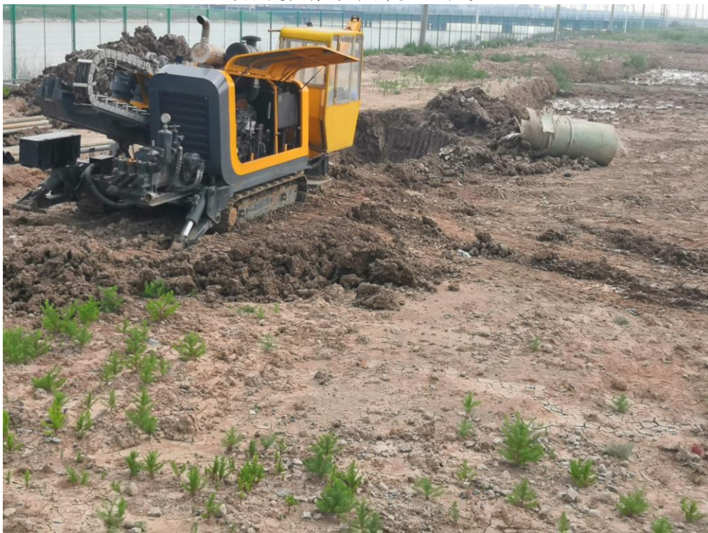
穿管段施工现状（正在施工，桩号0+460）
