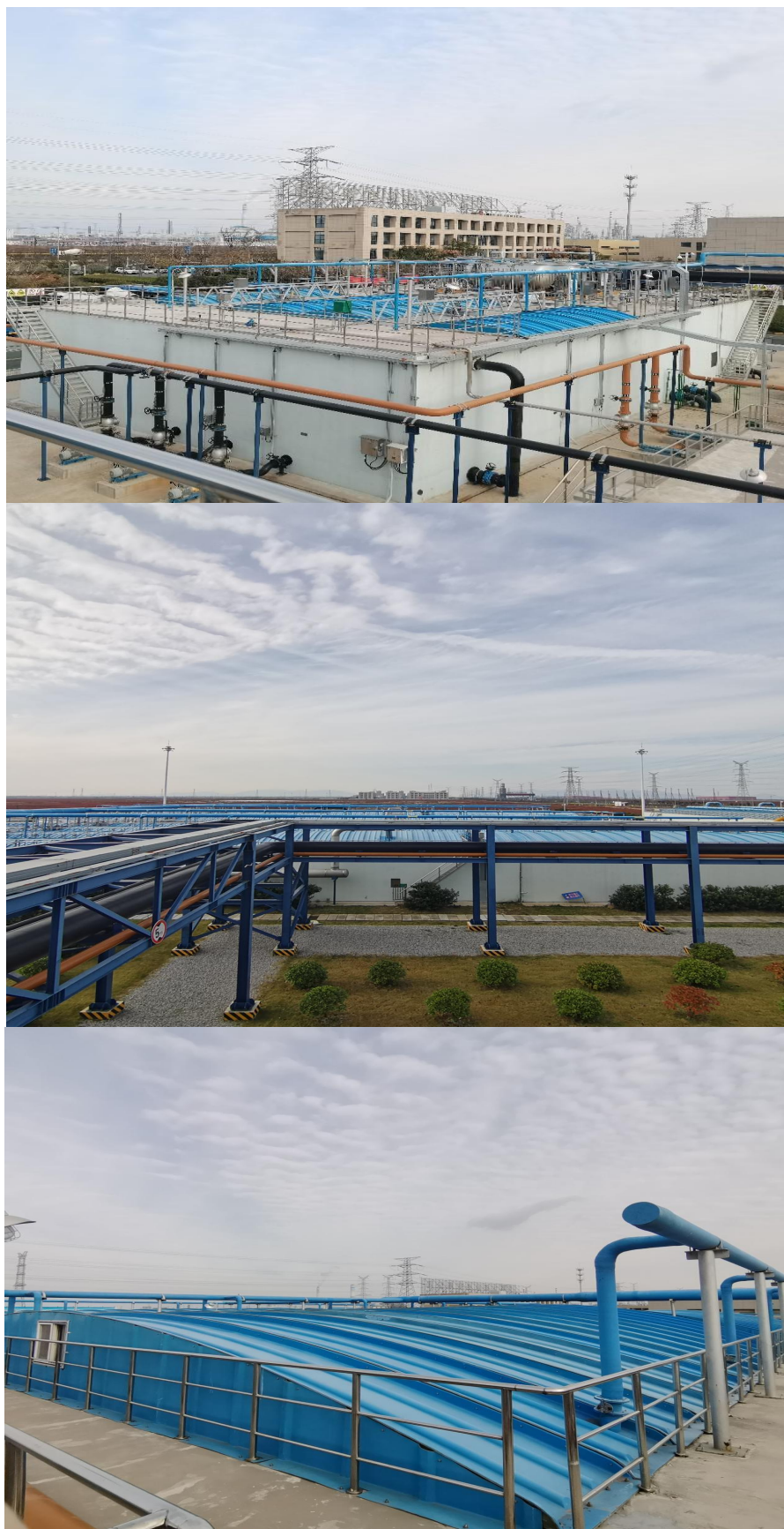
图 4.1.2-1 芬顿氧化、水解酸化池、A/O 池、酸化调节池加盖
