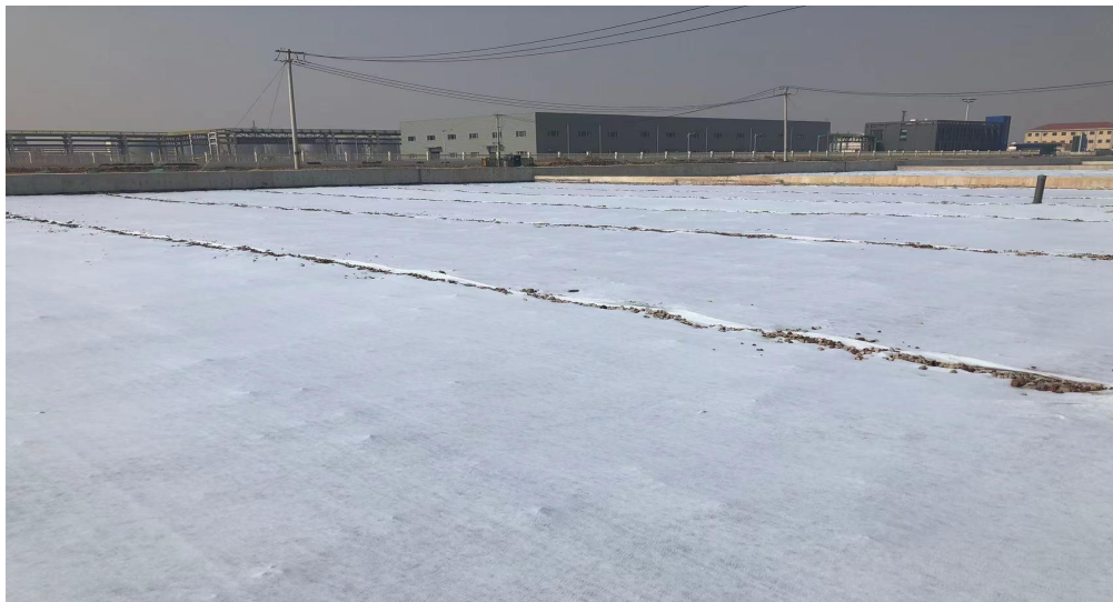
图 3-11 现场施工防渗层覆盖
