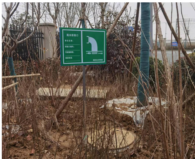
图 3-1 厂区生活污水化粪池排放口
